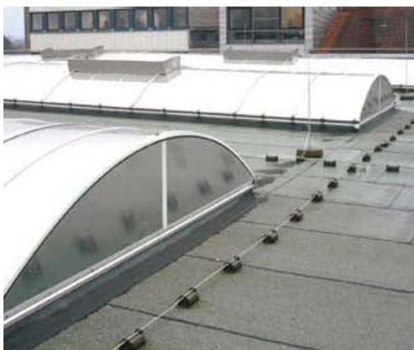
Alle Glasflächen auf dem Dach wurden mit Folie nachgerüstet.
