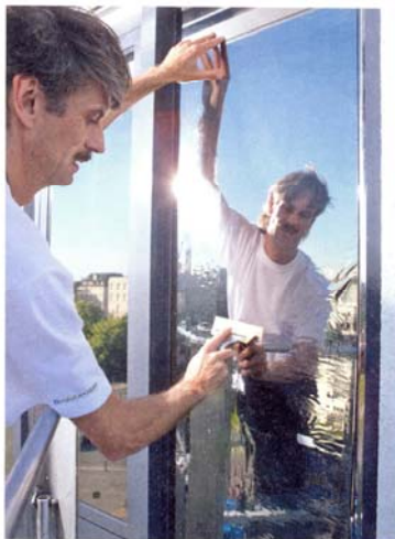
Bei der Verarbeitung müssen Fachbetriebe darauf achten, dass sich keine Luftblasen unter der Folie bilden. Foto: Haverkamp
