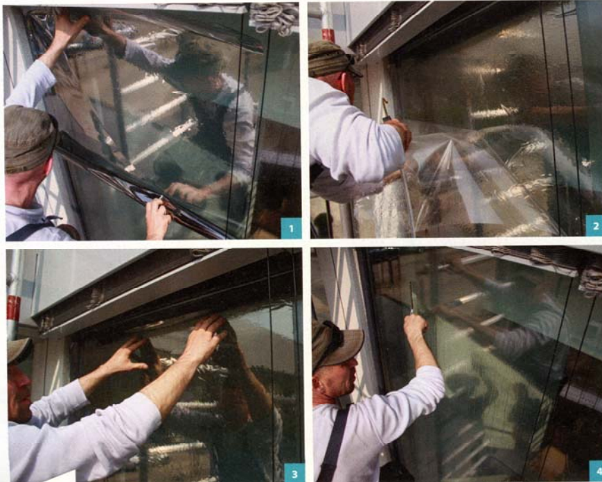
Folienmontage: Nach dem Zuschneiden wird die Folie mit Montageflüssigkeit benetzt auf die gereinigte Scheibe aufgebracht (1 und 2), und ausgerichtet (3). Anschließend werden mit einem Spezialwerkzeug von oben nach unten das Wasser und die Blasen aus der Folie herausgedrückt (4).
