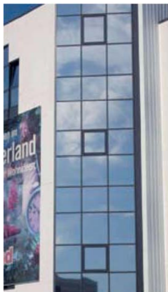
Das Raumklima wurde durch die Sonnenschutzfolien maßgeblich verbessert.
