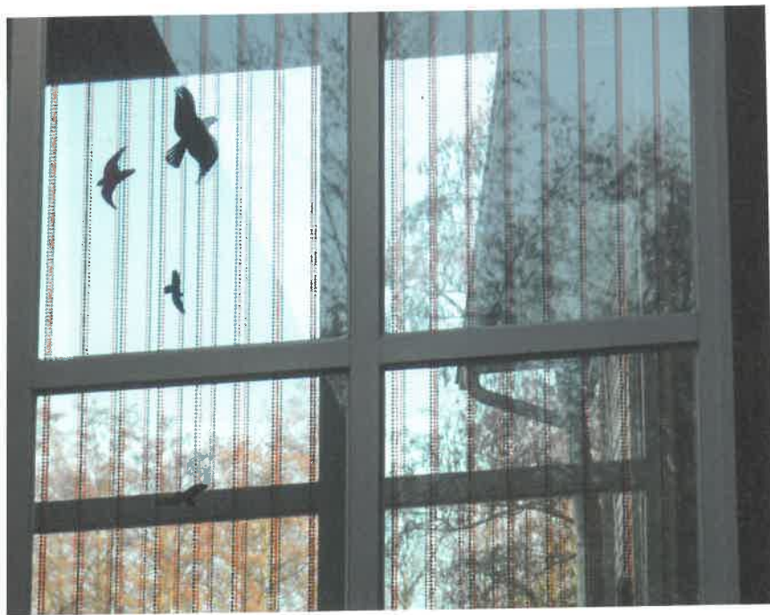
Das Verwaltungsgebäude des Biosphärenreservats Mittelbe mit der installierten Vogelschutzfolie.
