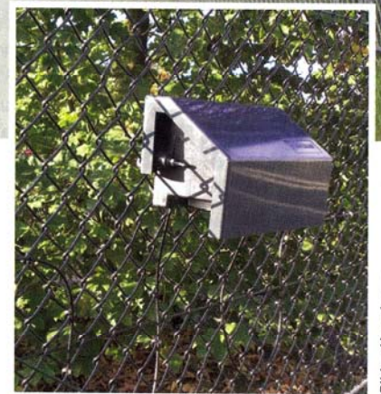
Das Sensorkabel wertet Schwingungen aus, wie sie typischerweise bei Manipulations- oder Überkletterversuchen entstehen.
