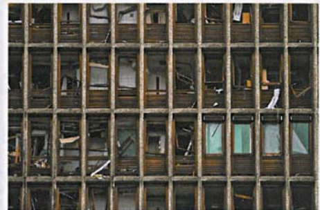
Nach dem Anschlag in Oslo: Der Unterschied ist deutlich sichtbar. Bei den mit sprengwirkungshemmender Folie abgesicherten Fenstern (rechts) blieb das zerstörte Glas im Rahmen. Bild: Henrik Lied (CC BY-SA 2.0)
