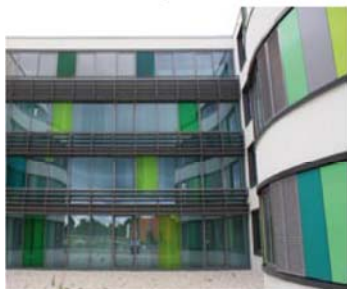
Alle Glasflächen des Gebäudes wurden mit speziellen Sonnenschutzfolien ausgestattet, die sich durch hohen Hitze- und Blendschutz auszeichnen.
