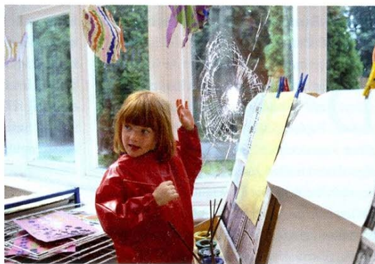
Kölner Schulen rüsten ihre älteren Brandschutztüren mit Splitterschutz-Folie aus. Bild: Haverkamp
