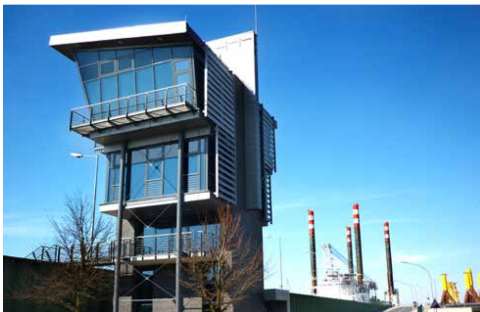
Der neue zentrale Steuerstand besticht durch seine großflächige Fensterfront.
